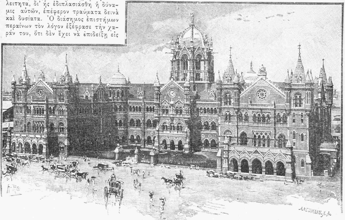
Ο ΚΕΝΤΡΙΚΟΣ ΣΙΔΗΡΟΔΡΟΜΙΚΟΣ ΣΤΑΘΜΟΣ ΤΗΣ ΒΟΜΒΑΗΣ
